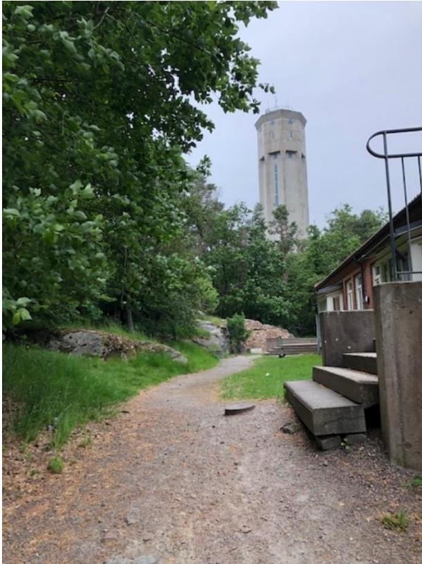
Figur 31. Baksidan av Katolska Skolan som visar lutning mot norr. Bilden är tagen på brytpunkt, bakåt lutar det mot grusplan.
