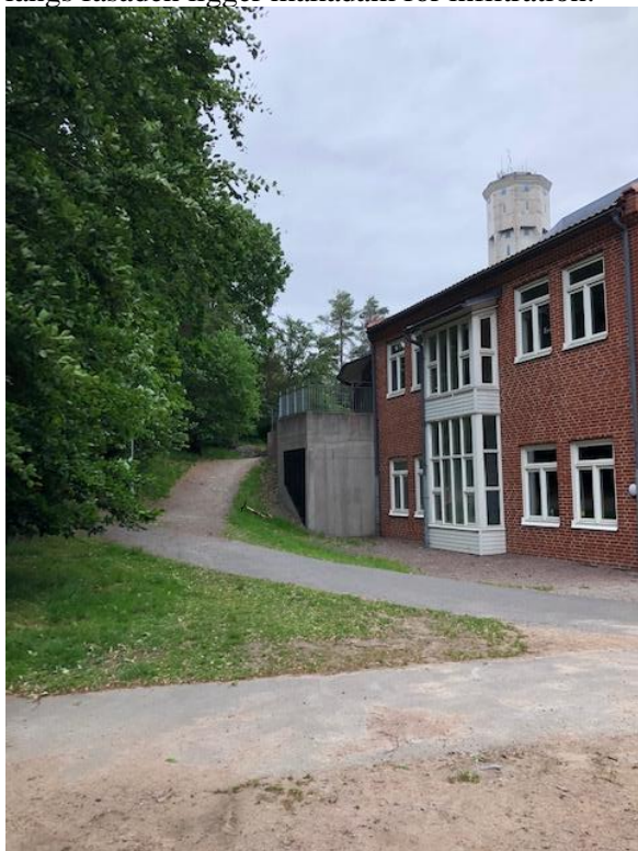
Figur 4. Lågpunkt vid skolan med makadamfyllning dit vatten rinner från skogsområdet som syns till vänster i bilden.
